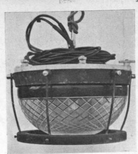
Fig. 3 - Dispositivo adibito in origine, per la pesca con luce subacquea. Nella base a l'accumulatore (3) e l'argano (4) con i fili conduttori della corrente (5) e con (X) massa su fondo marino.
