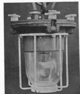
Fig. 2 - Lampada elettrica ad immersione senza riflettore interno, adibita nei primi esperimenti e costruita nel 1914.
